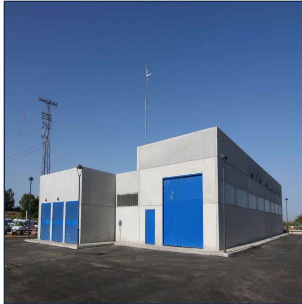
9 Estaciones de bombeo
