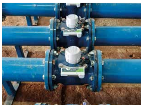
Instalación de módulo de comunicación para realizar telelectura.
