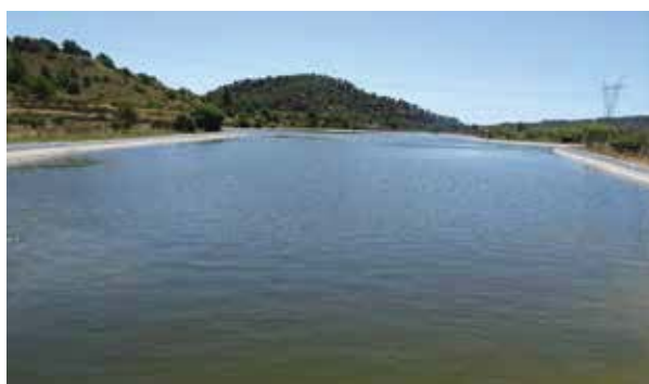
Fotografía nº 1.- Balsa de regulación de riego (Sin elementos de seguridad para salir del vaso)
