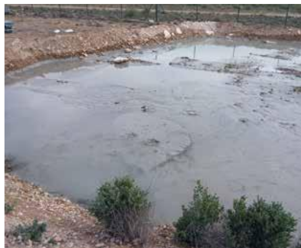
Fotografía 2. Represa construida para decantación de sedimentos extraídos de una balsa de agua bruta, y deshidratación por evaporación natural. Obsérvese que el color negro del fluido ya cambió a cenizo
