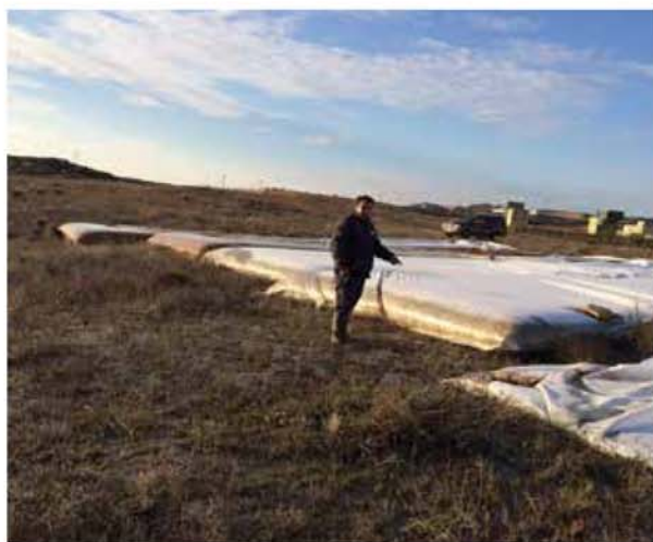
Fotografía 3. Sedimentos recogidos en sacas de 125 m 3 , a base de geotextil de material y porometría adecuada, para contención de áridos y limos gruesos, logrando una rápida oxidación de la parte orgánica arrastrada con el agua exudada
