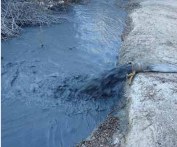
Fotografía 1. Descarga en balsete preparado al efecto, para decantación de los sedimentos del agua bruta extraídos de una balsa. El color negro se transforma a blanco ceniza en unas pocas horas, al oxidarse la componente orgánica.
