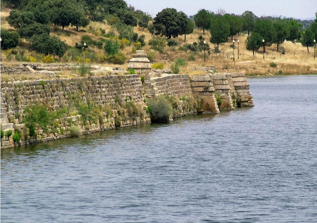
La presa de Proserpina se comenzó a construir en el S I a.C, tiene una capacidad de embalse de  $6,5 \text{ hm}^3$ , con una altura de 21 m y una longitud de coronación de 428 m.
