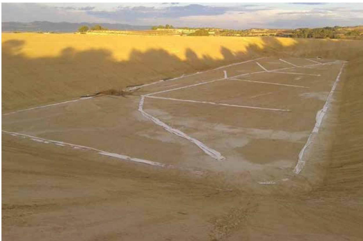
Figura 1. Dren de cintura y red ramificado para el control de fugas en los taludes y el fondo del vaso de una balsa, respectivamente.
