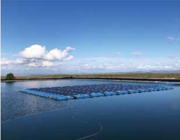
macenar el agua, sin necesidad de destinar parte del espacio de cultivo a la planta solar. Otra ventaja es que se reduce la evaporación del agua, hasta en un 80% de la superficie cubierta por la planta fotovoltaica, así como la reducción de la proliferación de algas, dos de los grandes problemas que tienen las balsas de riego.
