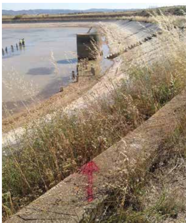
Operarios retirando bordillos del fondo de una balsa impermeabilizada con PEAD. A la derecha riostra rígida que hace de escala hacia el fondo
