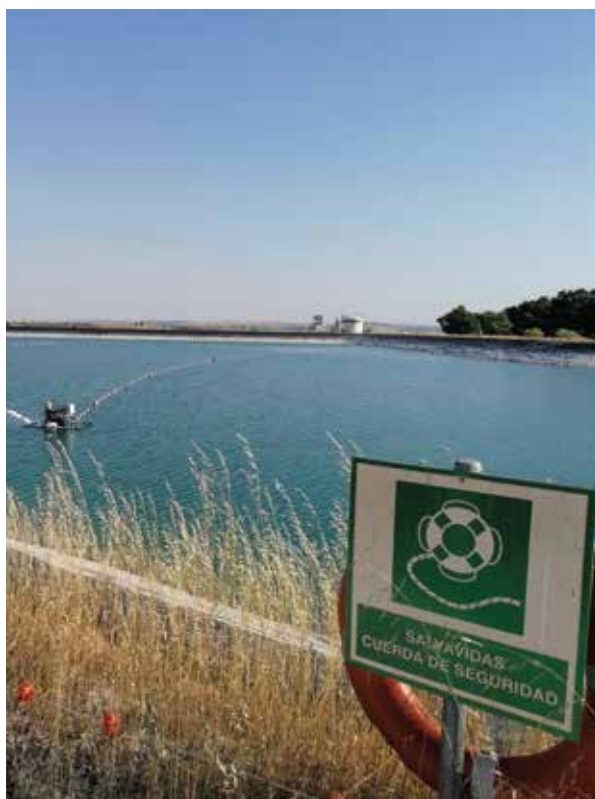
Extracción de sedimentos sin desembalsar y sin alterar la explotación ordinaria
