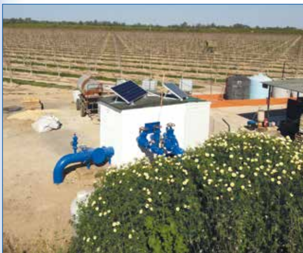
Localización de la planta piloto en Cortijo Calonge (Palma del Río, Córdoba)
