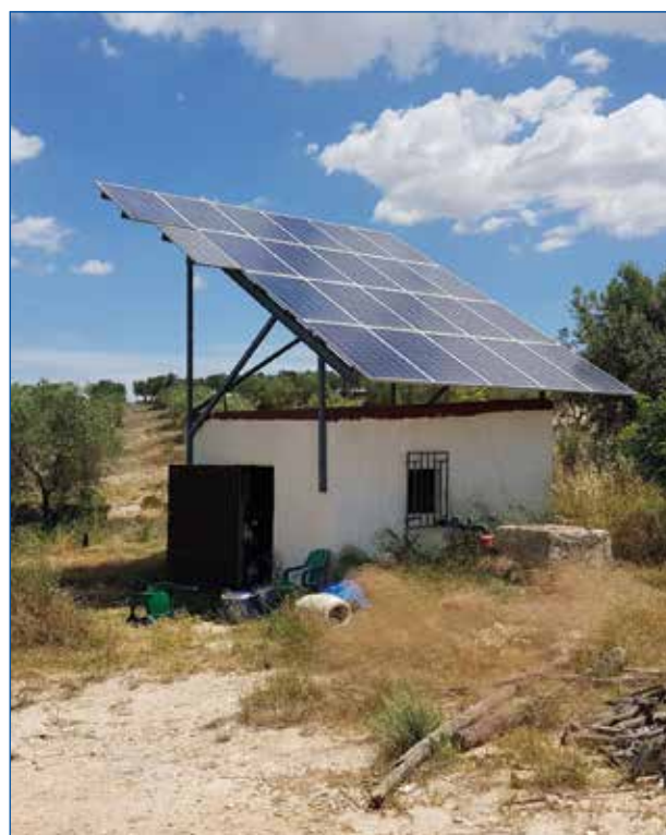
Figura 1. Instalación de riego fotovoltaico en un olivar de Tabernas (Almería).
